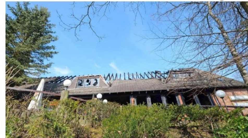
Das Bahrenfelder Forsthaus nach dem Brand (Archivfoto)
